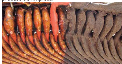
Figura 6. Fotografía comparativa del proceso parcial de limpieza criogénica
